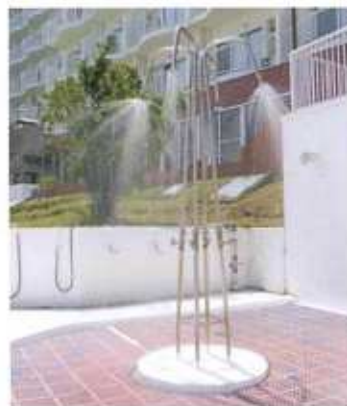
プールシャワー設置
